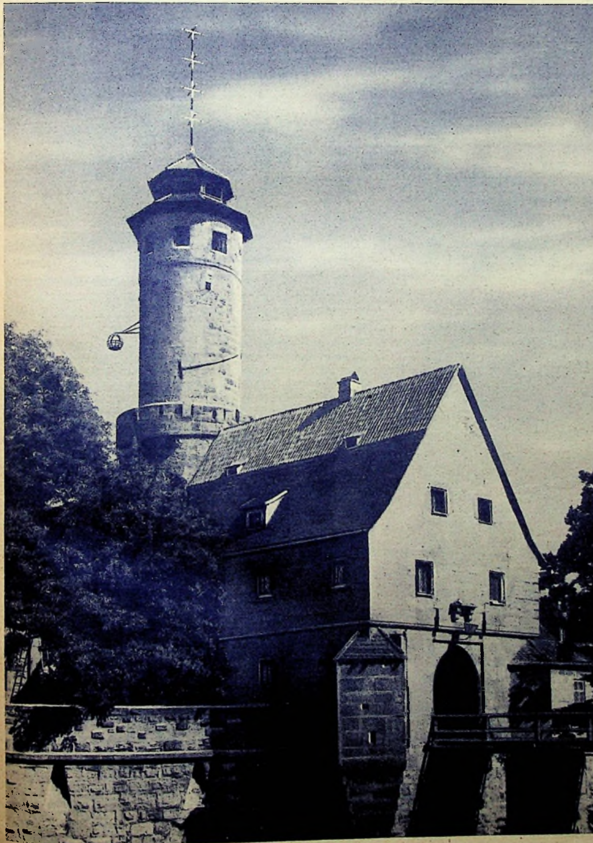
Der UKW-Sender Bamberg des Bayerischen Rundfunks, der mit 1 kW Leistung auf 87,7 MHz das Münchener UKW-Programm überträgt, bietet ein gutes Beispiel für die vorbildliche architektonische Eingliederung der Sendeinrichtungen in den Baustil der ehrwürdigen Altenburg.
